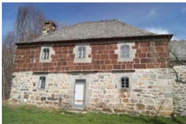
Figure 16 : Ferme du Bois de Peyrala, Borée (07) présentant au rez-de-chaussée du granit dégrossi, à l'étage du basalte taillé et des trachytes clairs pour les encadrements des ouvertures.
