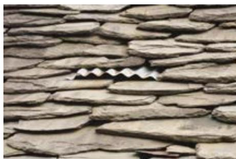
Figure 117 : Tôle remplaçant ponctuellement une lauze
