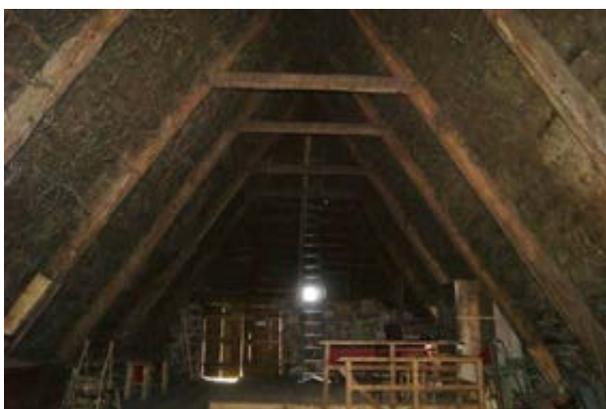
Figure 152 : Charpente de la ferme et emplacement de l'ancien étage du logis est
