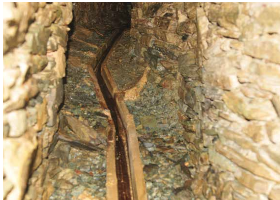
Cette galerie de captage, assez haut dans la montagne, pénètre au moins à une trentaine de mètres, un effondrement ne permettant pas de mesurer sa longueur totale (cliché A. Gauthier).
