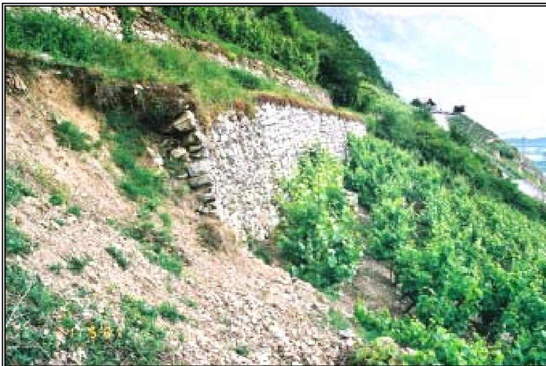
**Photo 3 : Chemin didactique des guérites et des vignes. Exemple de remplacement d'un mur en pierre sèche par des traverses CFF (Fully).**
