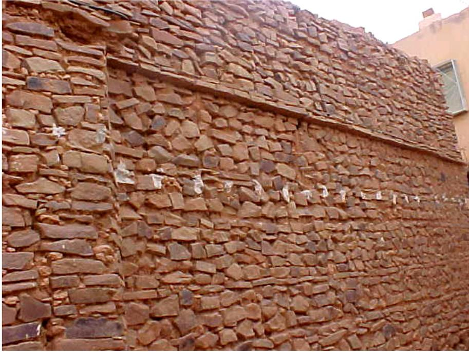
Fig. 32 : Construction en pierre à Kenadsa (2004). C'est un mur rempart qui nous fait face. Mais loin de dégager un effet statique et rigide, l'appareillage des petites pierres sèches avec des assises intercalées en pose horizontale et en pose en biais donne au mur une vibration qui dégage un effet de mouvement et de vie.
